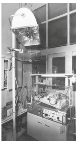
links: stationäre, mitte: mobile Phototherapie-Einrichtung – unser Beitrag 1981 zur Senkung der Säuglingssterblichkeit
